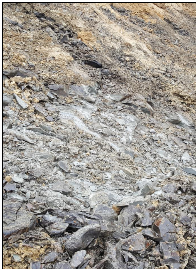
Foto 2: sondažni izkop S-2
