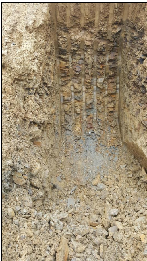
Foto 1: sondažni izkop S-1
